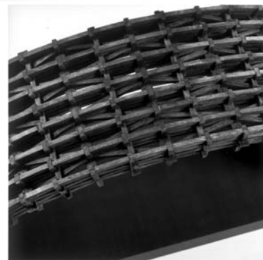
Pont de Neuilly : cintre en charpente ayant servi à la construction fin XIX e inv. 8637.
