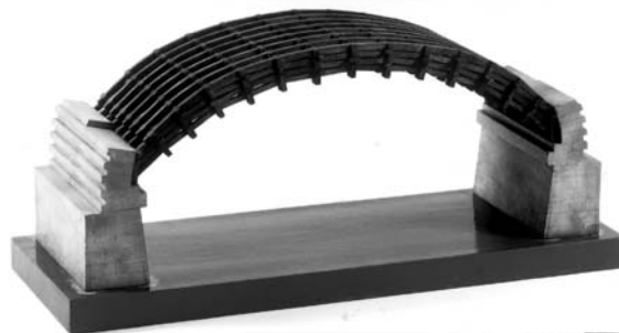
Pont de Neuilly : cintre en charpente ayant servi à la construction fin XIX e inv. 8637.
