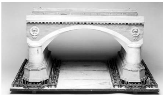
Arche du pont en pierre de Bordeaux, maquette au 1/25, 1819, inv. 8707.
