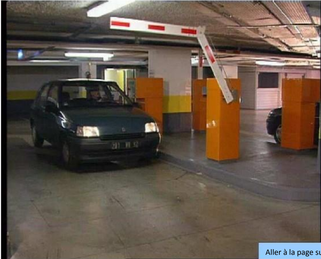
Barrière de parking
