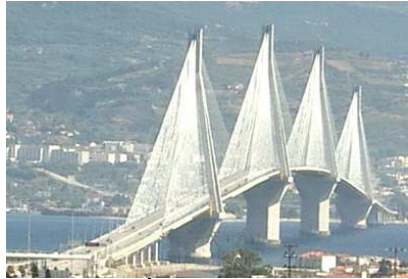
2004 Pont de Rion Anthirion (Grèce)
