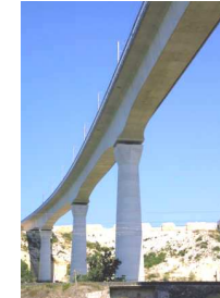
1998 viaduc ligne TGV Avignon (F)
