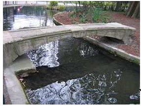
1855 Premier pont en béton de Louis Vicat (F)
