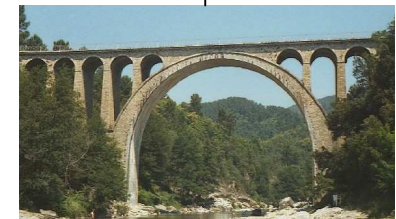
1900 Pont des Abarinnes
