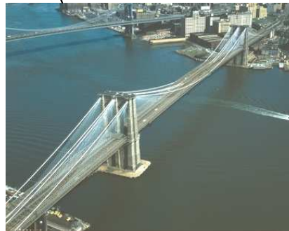
1883 Pont de Brooklyn (USA)
